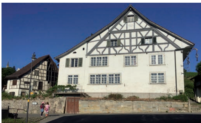
Baudenkmal in Rüdlingen/SH (17. Jh.): Im Wirtshaus zum Rebstock soll künftig gewohnt werden.
