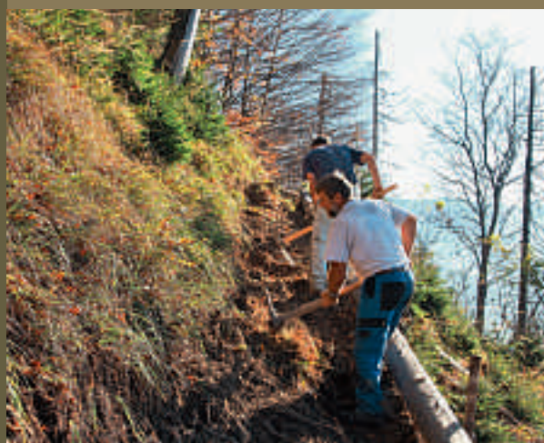
Construction d'un sentier au Dossenmätteli
