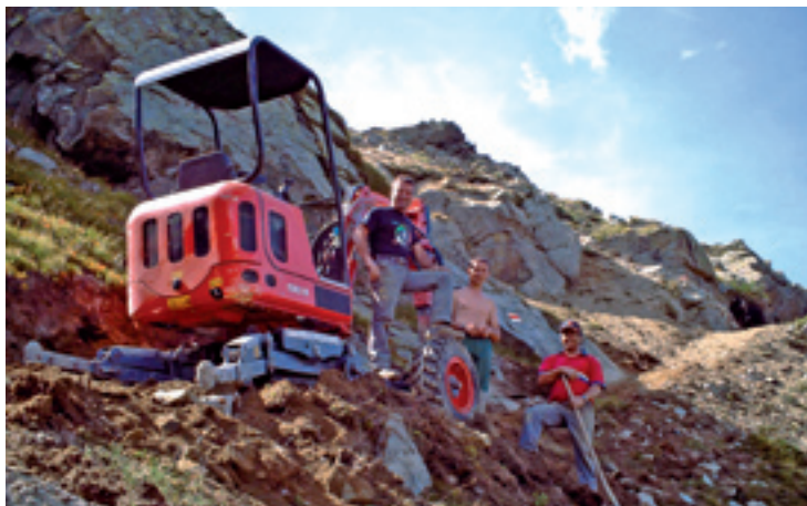
Operai impegnati nei lavori di spostamento del sentiero
