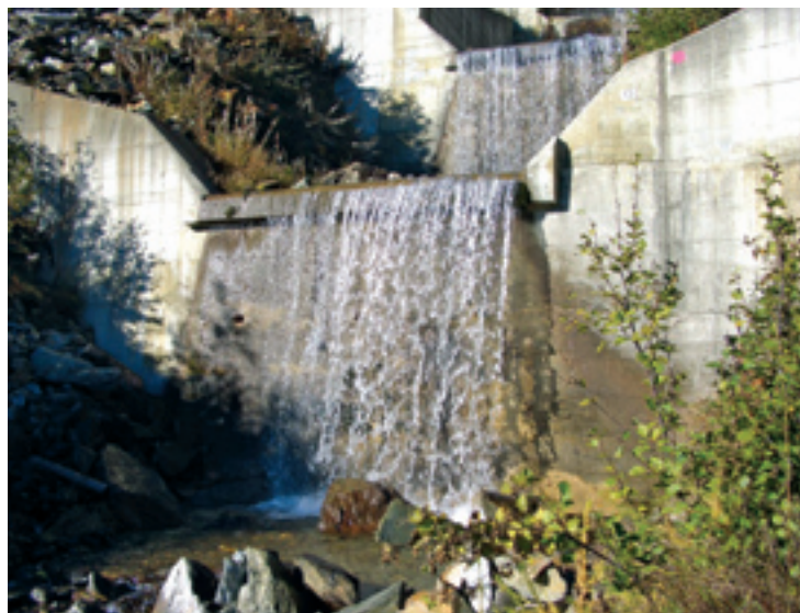
Briglie di contenimento in calcestruzzo lungo il torrente Val Varuna
