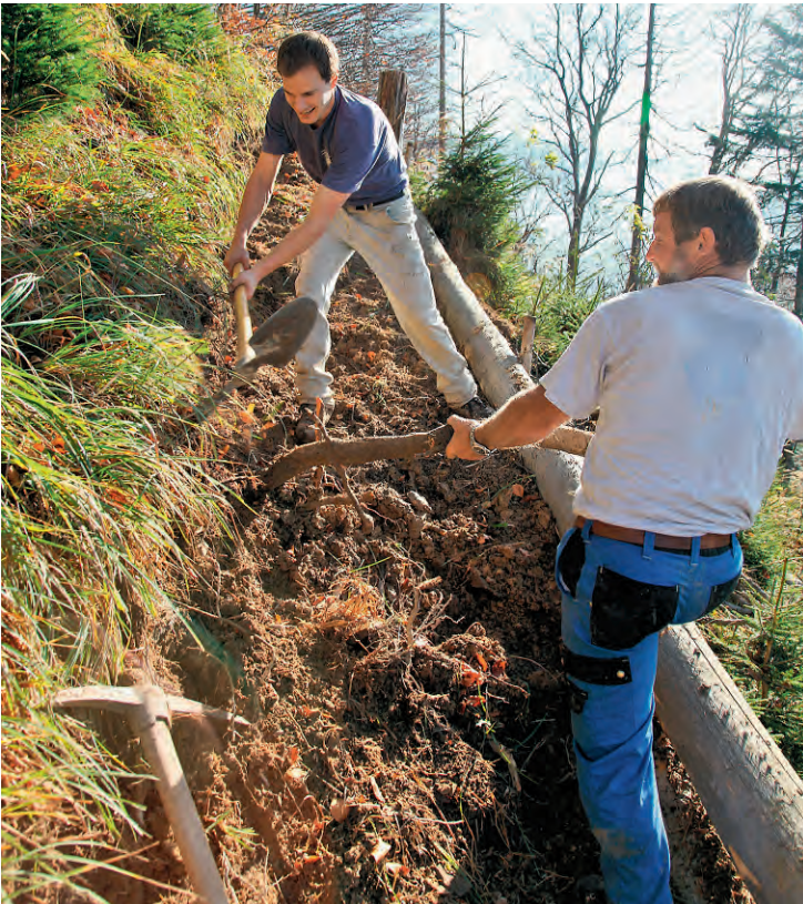
Wegbau im steilen Gelände.
