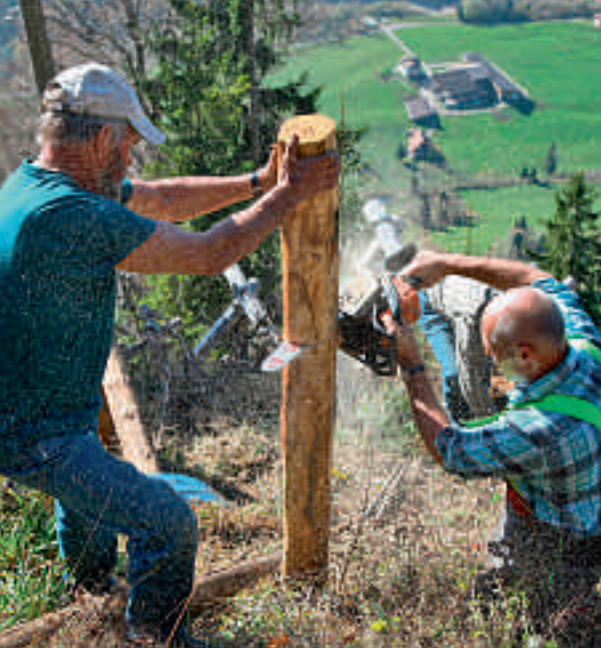
Bau der Ogiböcke
