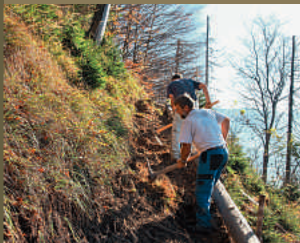
Wegbau am Dossenmätteli
